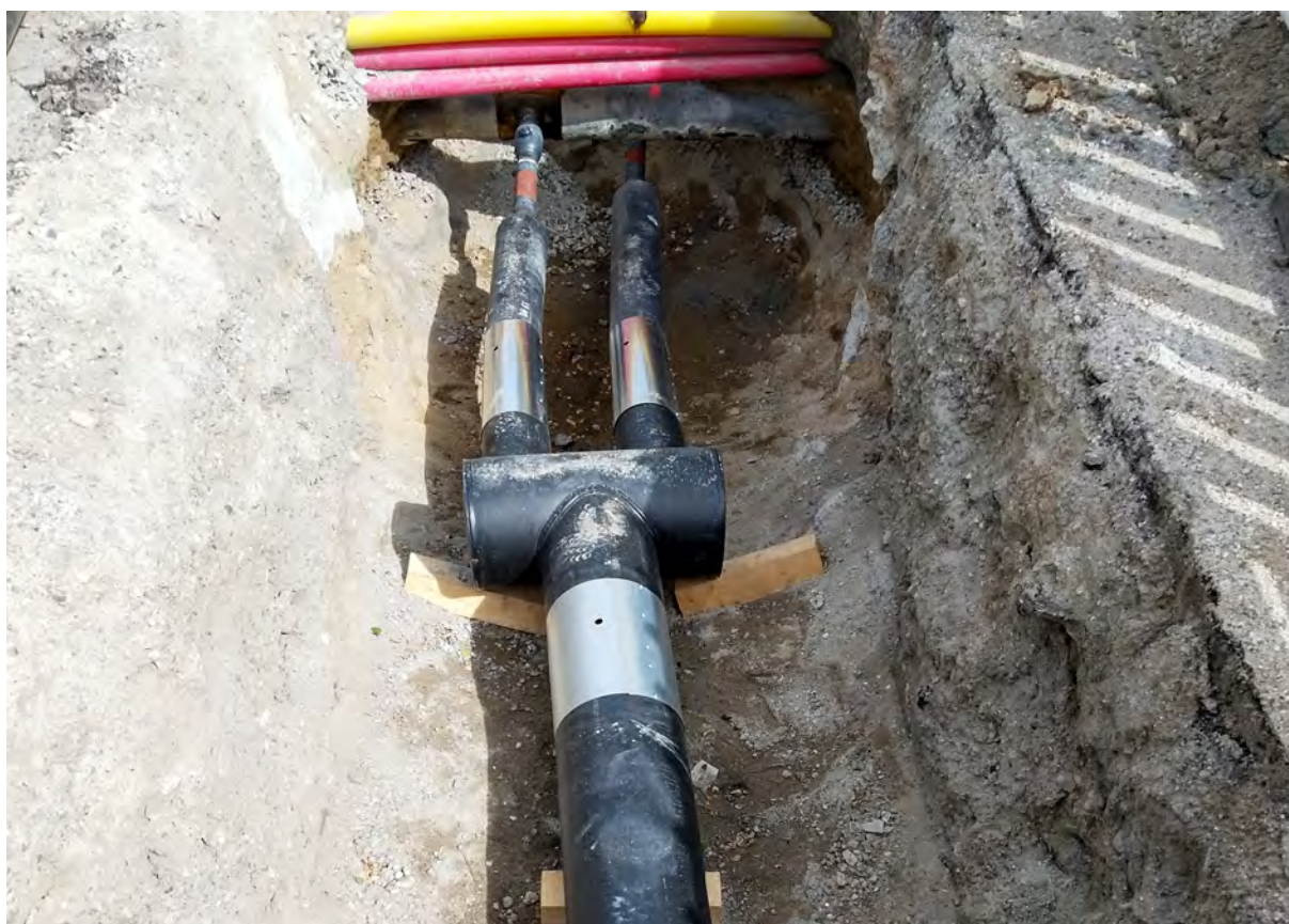
Rörledningsinstallationer under arbete
