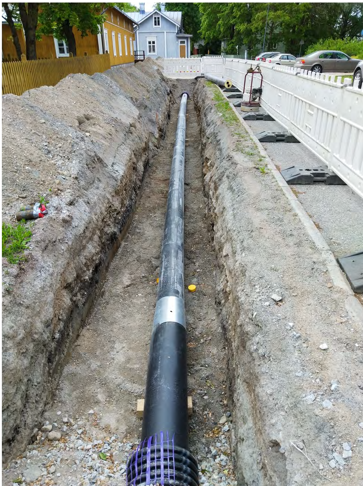
Putkilinjan rakentaminen vanhalla malmilla
