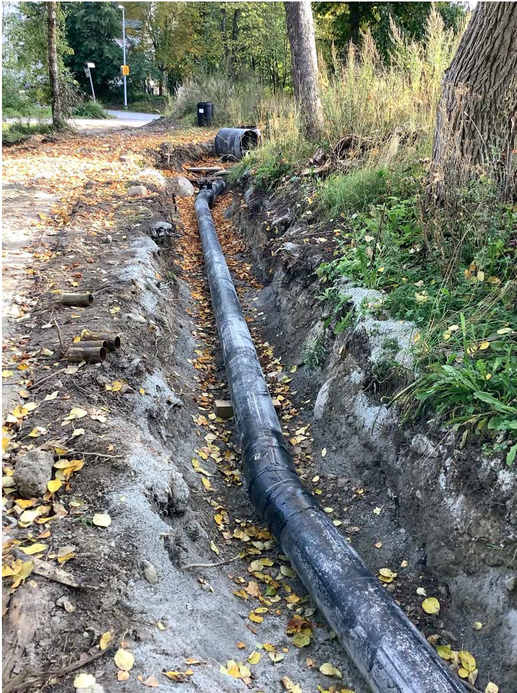
Putkilinjat vedetään usein pyörä- ja kävelyteitä pitkin
