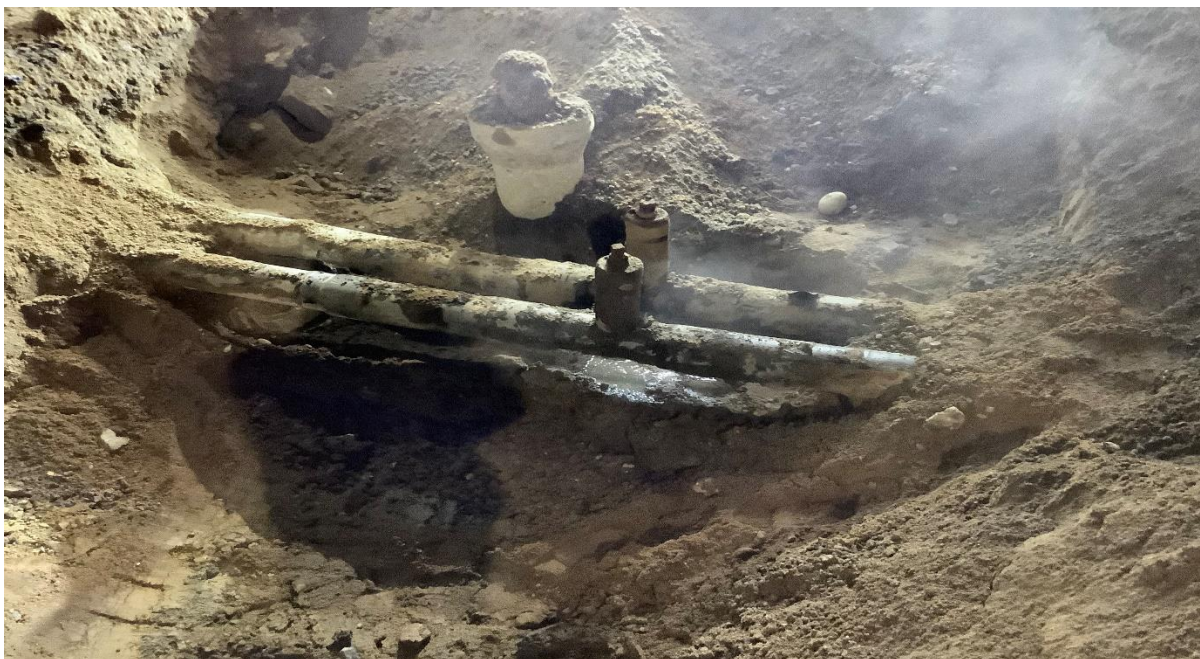
Reparationsarbeten på fjärrvärmenätet vid Gamla Bläsnäsvägen
