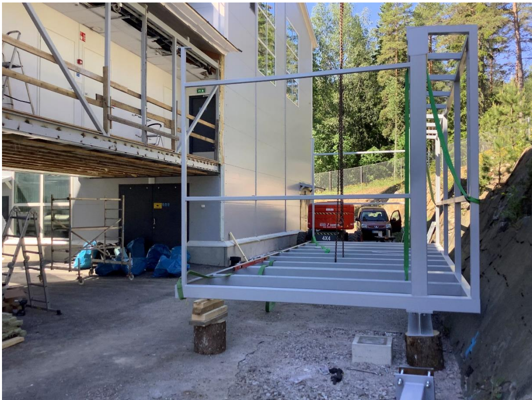
Valvomolaajennuksen teräsrunko valmiina nostoon.
