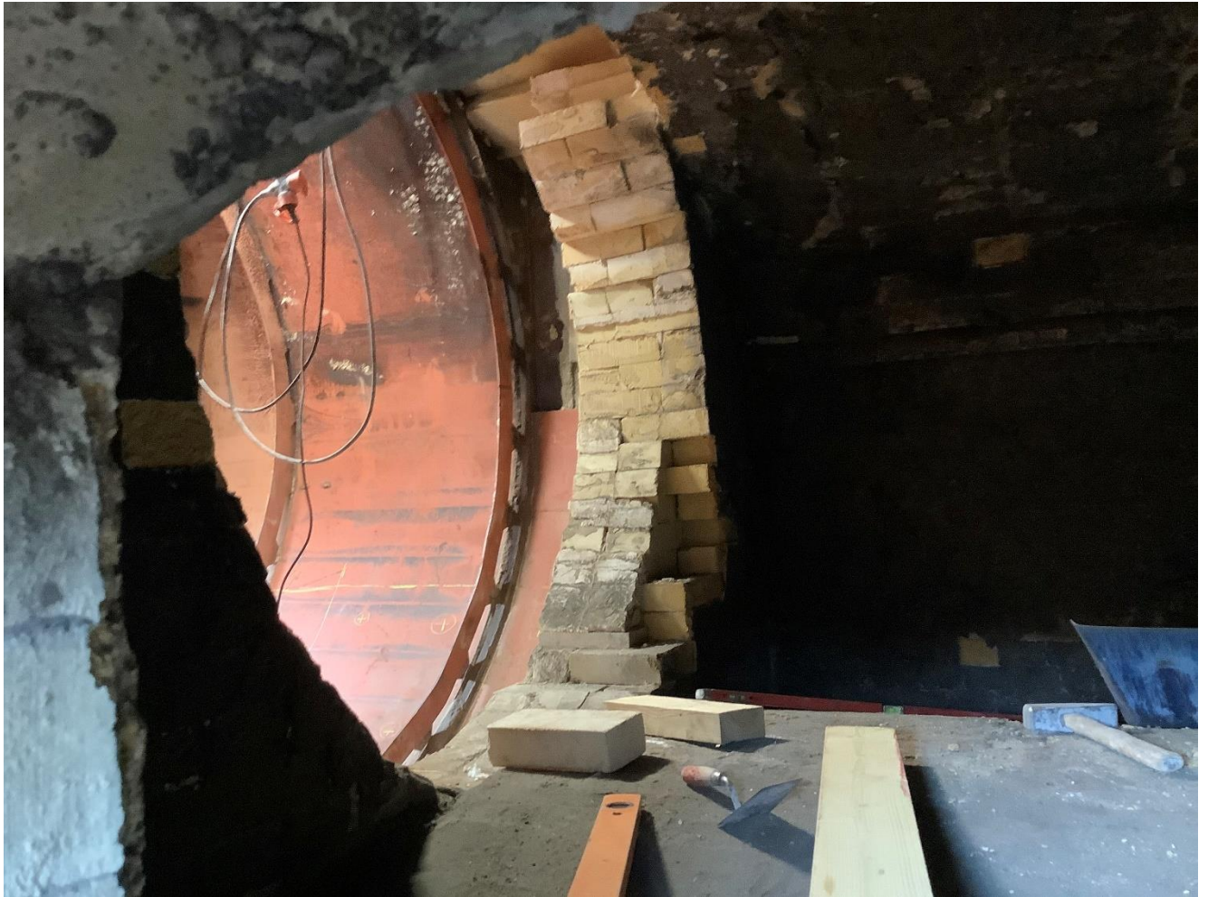
Bio 1 kattilan tertiäärikanavan korjaustyöt
