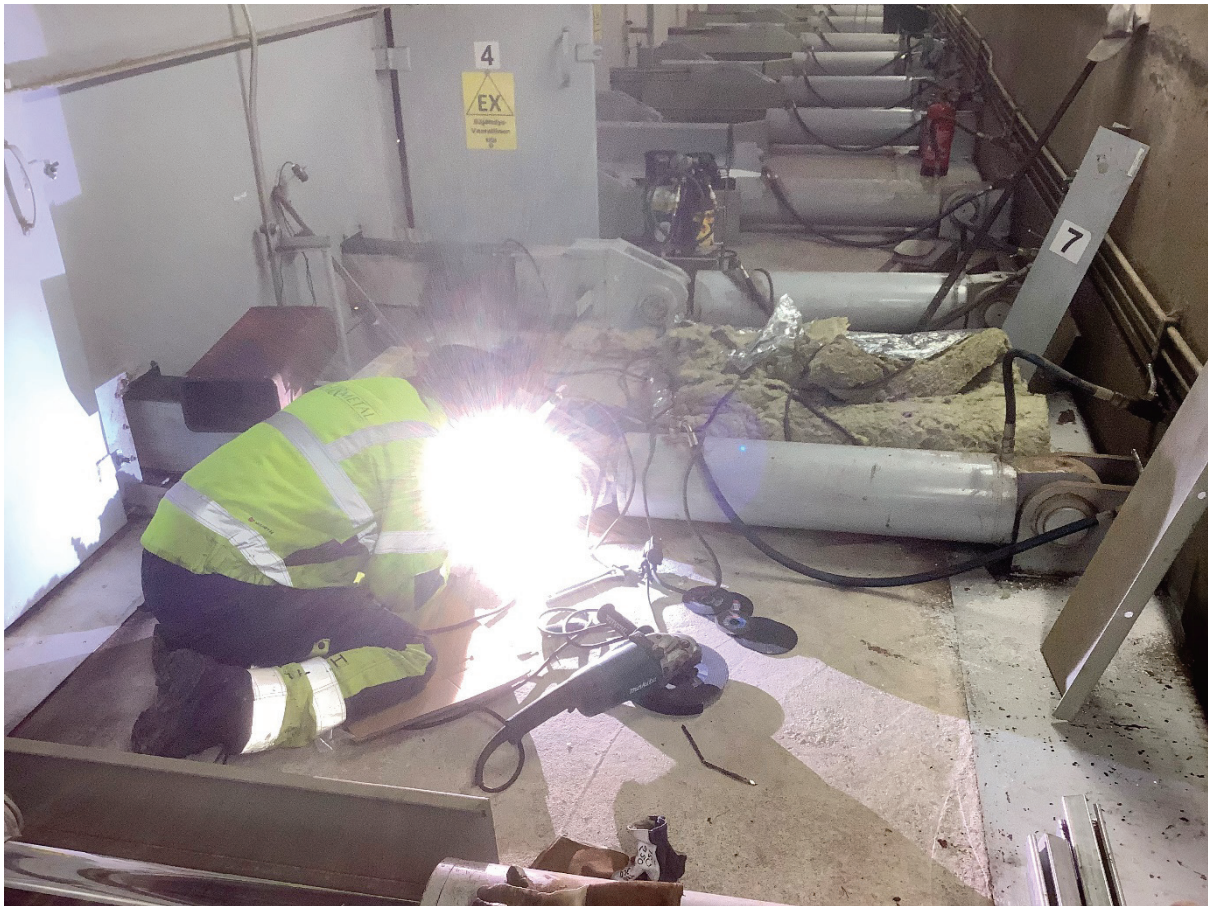
Årsservice på cylindrarna i bränslelagret
