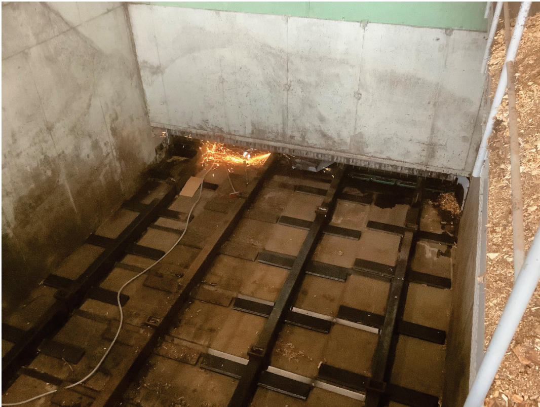
Hakevaraston siilon peruskorjaus.
